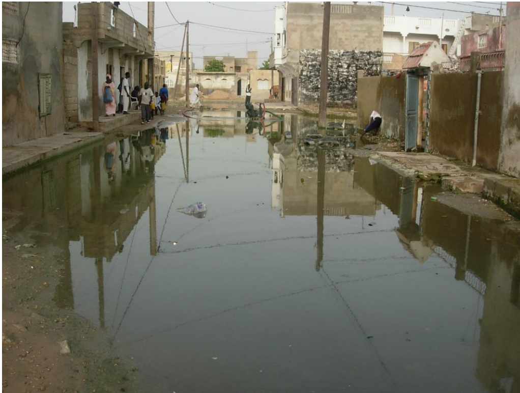
Figure 9 : photo du quartier de Cité Niakh à Saint-Louis en septembre 2007 (Malou, 2007)
