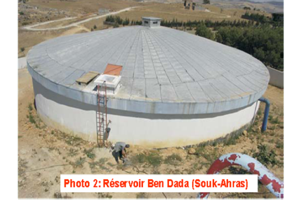
Photo 2: Réservoir Ben Dada (Souk-Ahras)
