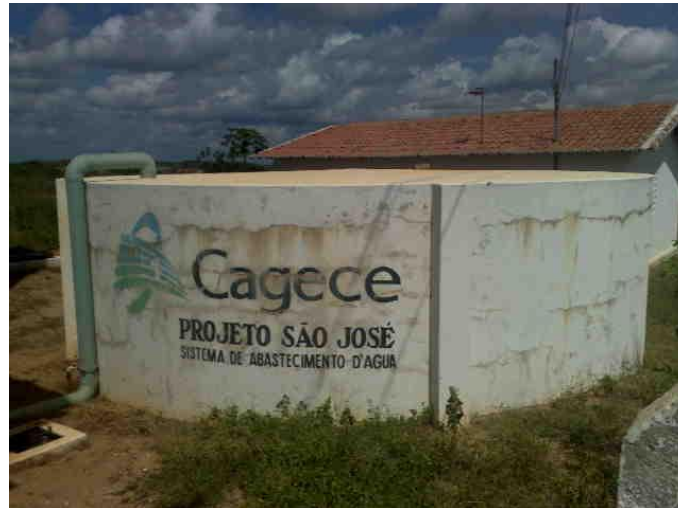
Figura 13 – Reservatório Apoiado – RAP. Fonte: Própria, 2010.
