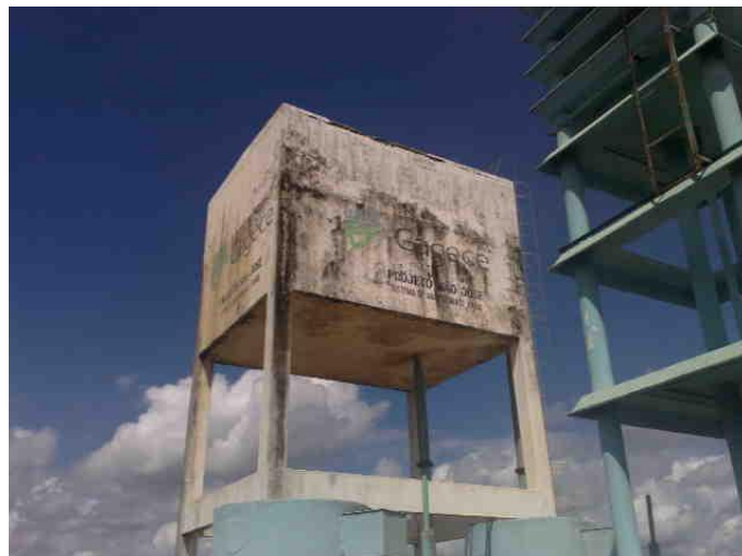
Figura 12 – Reservatório Elevado – REL. Fonte: Própria, 2010
