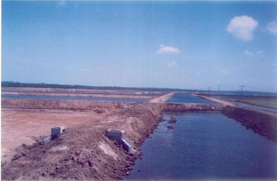
**Figura 02:** Comporta de abastecimento do Canal de Abastecimento (CA) para o viveiro 13, dique natural construído com material originado do terreno e o Canal de Abastecimento Interno (CAI).
