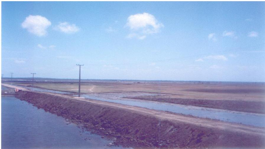
**Figura 03:** Dique recoberto de piçarra e talude revestido na parte inferior com pedras.
