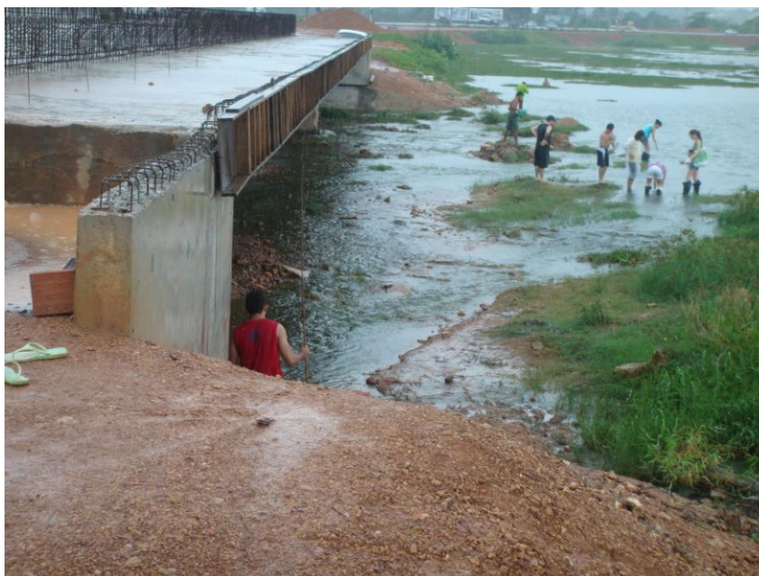
Figura 09: Construção do sangradouro, sob a ponte da Av. Manuel Mavignier.
