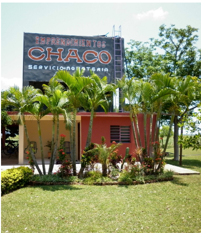
Elevated tank of Emprendimientos Chaco
