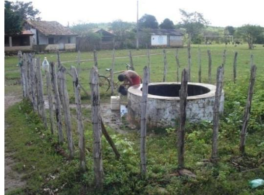
Exemplo de atividade em poço amazonas (cisterna), solução alternativa coletiva de abastecimento de água, devidamente cercado, mas sem laje e tampa de proteção, nenhum processo de desinfecção e limpeza, no povoado de Canto da Palmeira no Município de Esperantina/PI.
