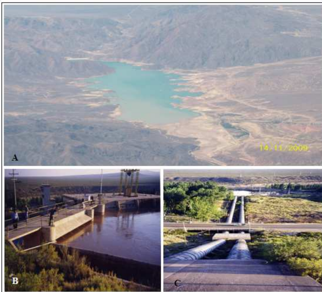
Figuras 02 (A)Dique Potrerillos (B)Central Álvarez Condarco (C)Tubulações Central Gen.San Martin
