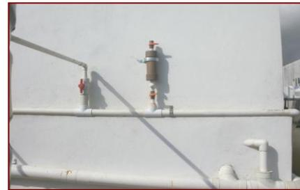
Clorador simplificado instalado no reservatório de água do BRABATT
