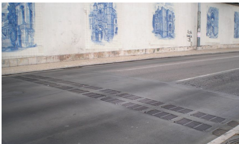
Figura 9. Grade transversal ao arruamento a montante da Praça 8 de Maio.
