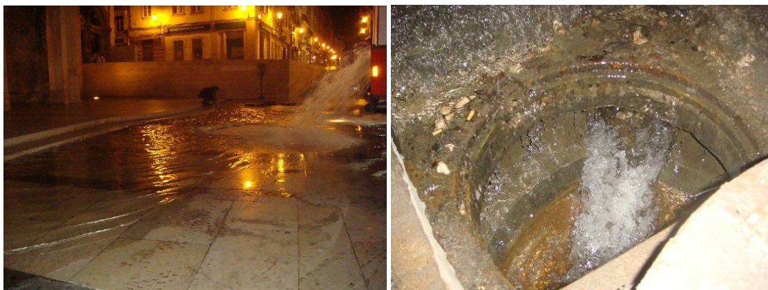
Figura 10. Ensaio de inundação na Praça 8 de Maio.
