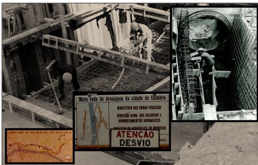
Figura 1. Construção do colector pentagonal, Rua da Sofia, década de 70.
