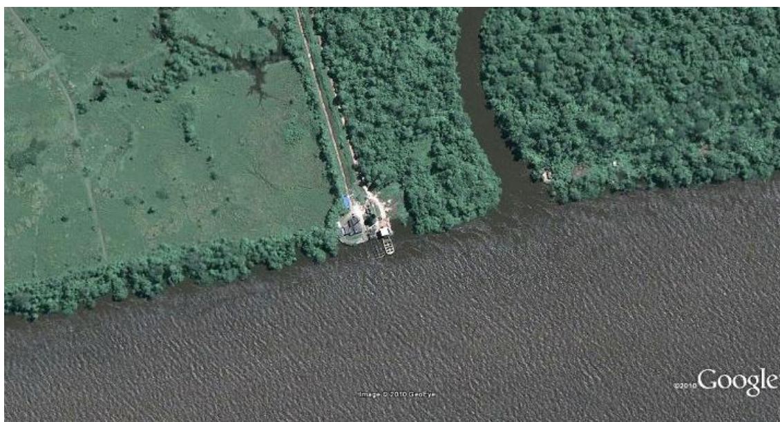
Figura 1 – Vista aérea da adutora que leva água do Rio Guamá ao lago Água Preta.
