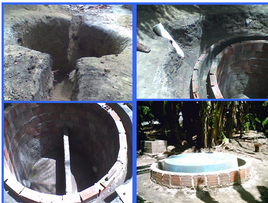
**Figura 2** – Mosaico da construção dos Biodigestores. – Fotos PMJP/SEDESP
