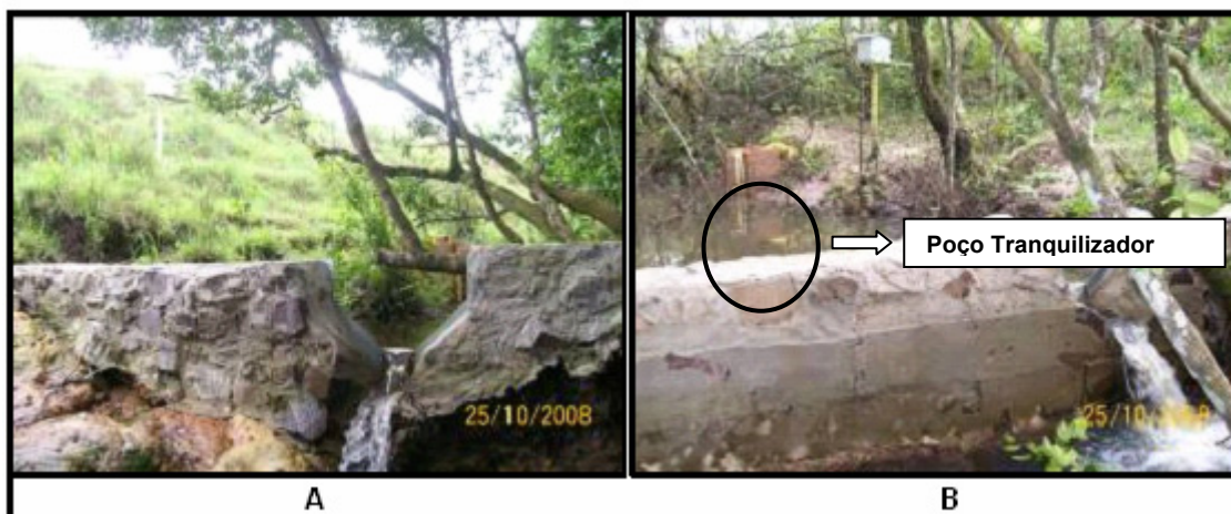
Figura 4– Estrutura hidráulica com poço tranquilizador da microbacia de campo (A) e da microbacia florestada (B). (Acervo GERHI)
