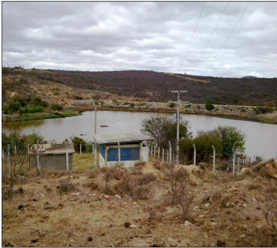
Figura 6: Área da casa de bombas da captação de Aracatu.
