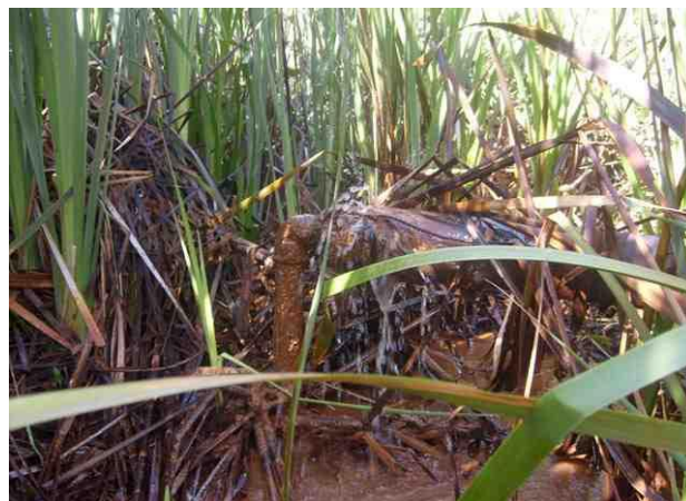
Figura 46: Tomada d'água na descarga de fundo.
