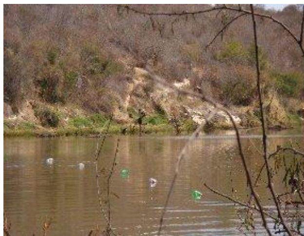
Figura 18: Rede de contenção presa às margens e suspensas por bóias de garrafa PET.
