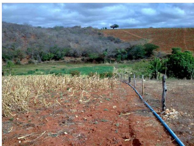
Figura 01: Fazenda Jacaré. Extremidade da barragem onde se iniciou os estudos.
