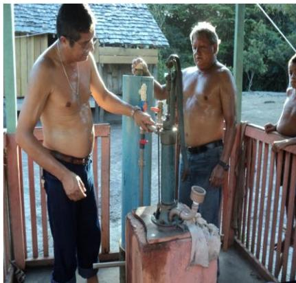
Filtro acoplado à bomba manual
