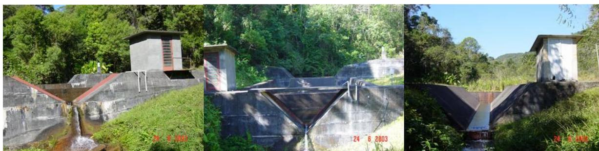
FIGURA 3 – Estações fluviométricas e vertedouros das microbacias hidrográficas experimentais A, B e D.
