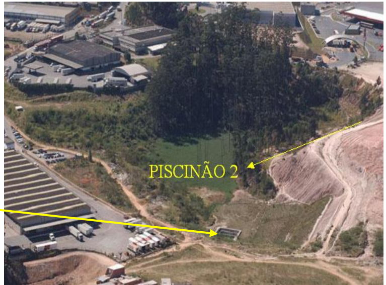
Fig.19 – Reservatório de Detenção 2 (obra inacabada)
