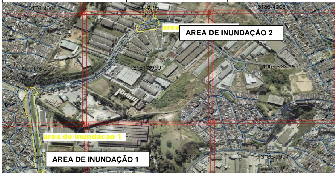
Fig. 11 – (Aerofotografia) Áreas de inundações na Av. Lourenço Belloli
