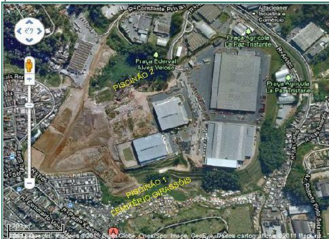
Fig. 18 - Visão geral da área onde foram construídos os Reservatórios de Detenção 1 e 2 (obras inacabadas)
