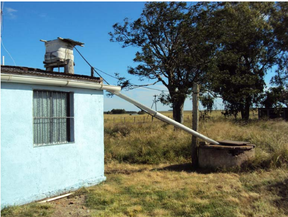
Figura 2 – Captação de água da chuva para reabastecimento de poço escavado de grande diâmetro Dom Pedrito/RS. Terrenos sobre Aquitardos Permianos com água salobra, Formação Irati.
