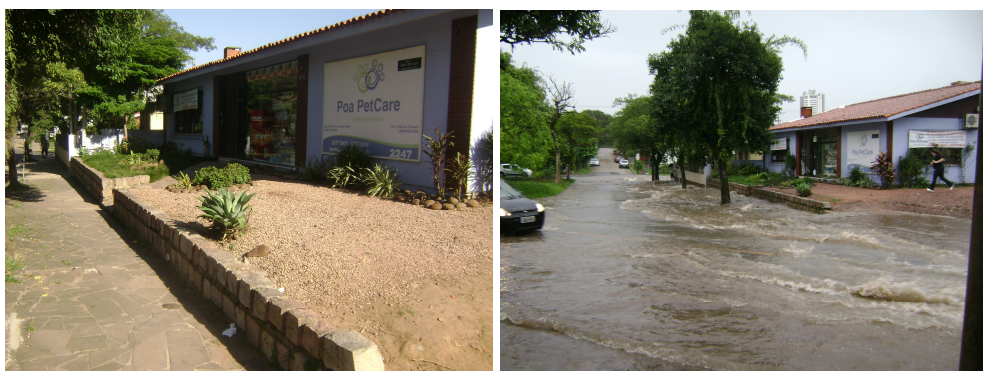
Figura 7. Modificação empregada por um proprietário para conviver com os constantes alagamentos.
