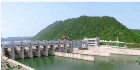
分水江水利枢纽大坝健康管理
