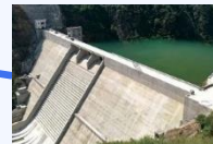
混凝土重力坝 Gravity dam
