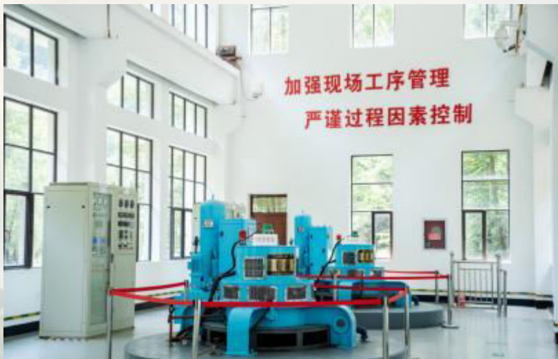
门溪电站 Menxi power station
