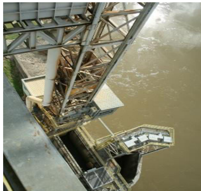
升鱼机 Fish lift
