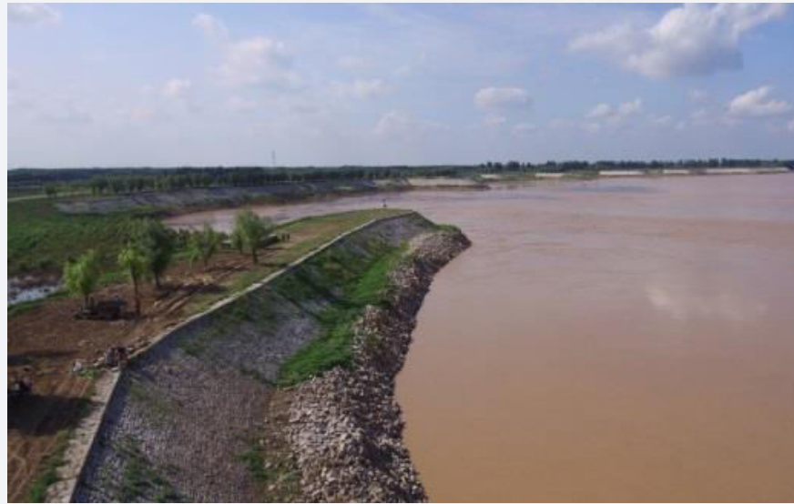
Riprap revetment
