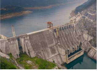
已建世界最高碾压混凝土重力坝 **龙滩水电站大坝** (216m)
