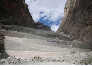
已建世界最高沥青混凝土心墙堆石坝, **去学水电站大坝** (164.2m)
