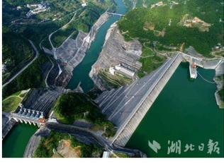
已建世界最高混凝土面板堆石坝, **水布垭大坝** (233m), 在建**大石峡面板堆石坝** (247m)
