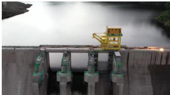
赞比亚下凯富峡水电站
