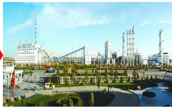
能源高效用水
