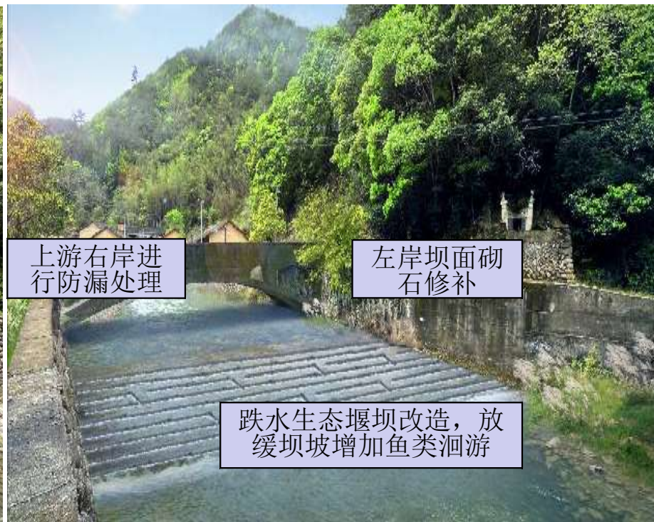
改造后效果图（斜坡式）
