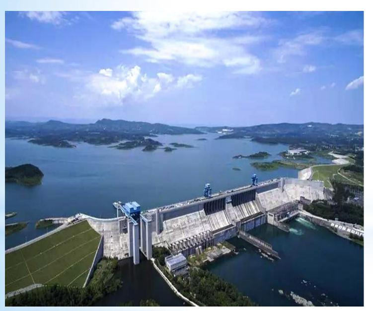
大坝加高工程技术复杂 施工难度大。大坝加高施 工期间, 枢纽仍处于正常 运行状态,需要协调好工 程加高施工和枢纽正常运 行调度之间的矛盾。大坝 加高工程贴坡混凝土温度 控制要求高难度大,为满 足混凝土温控要求以及安 全度汛,贴坡混凝土及溢 流坝的加高不能全年施工 只能在低温季节和枯水期 进行。
