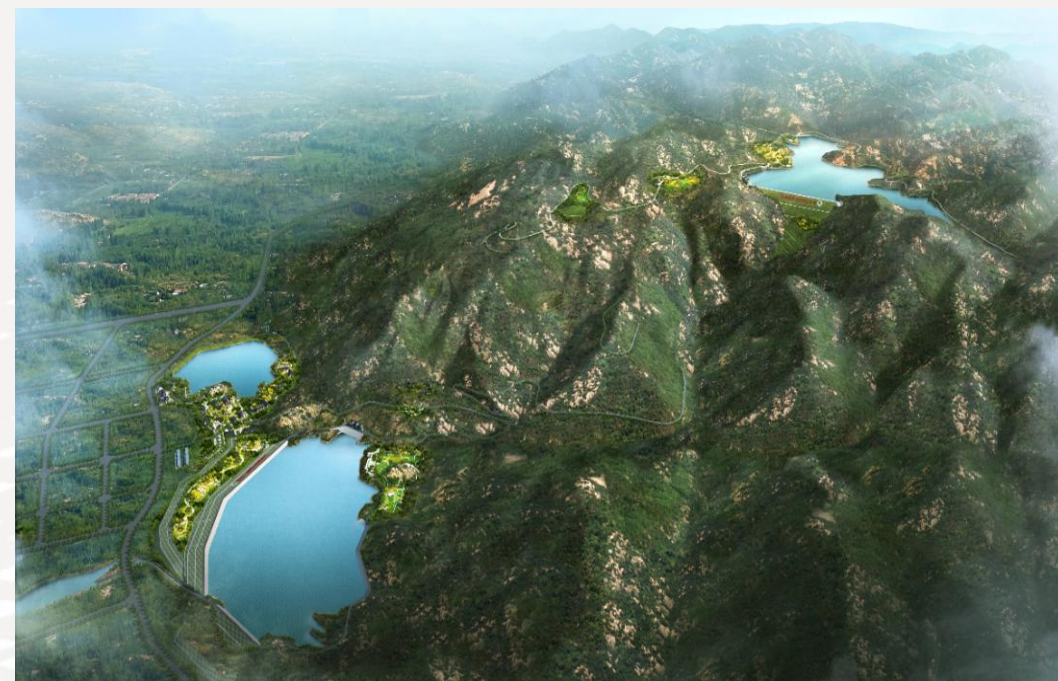
山东泰安抽水蓄能电站
