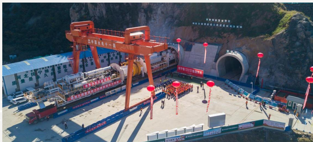
抚宁项目应用世界首台大直径（直径9.5米） 超小转弯半径TBM
