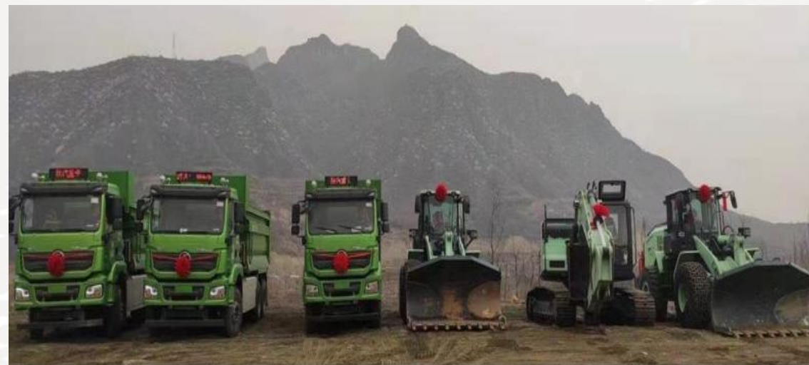
易县抽水蓄能电站电气化土方车辆
