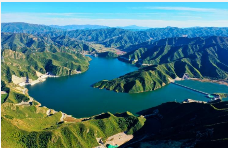
丰宁抽水蓄能电站下水库
