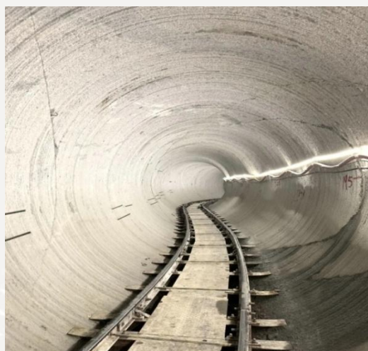
文登项目排水廊道TBM 掘进效果（直径3.5米）
