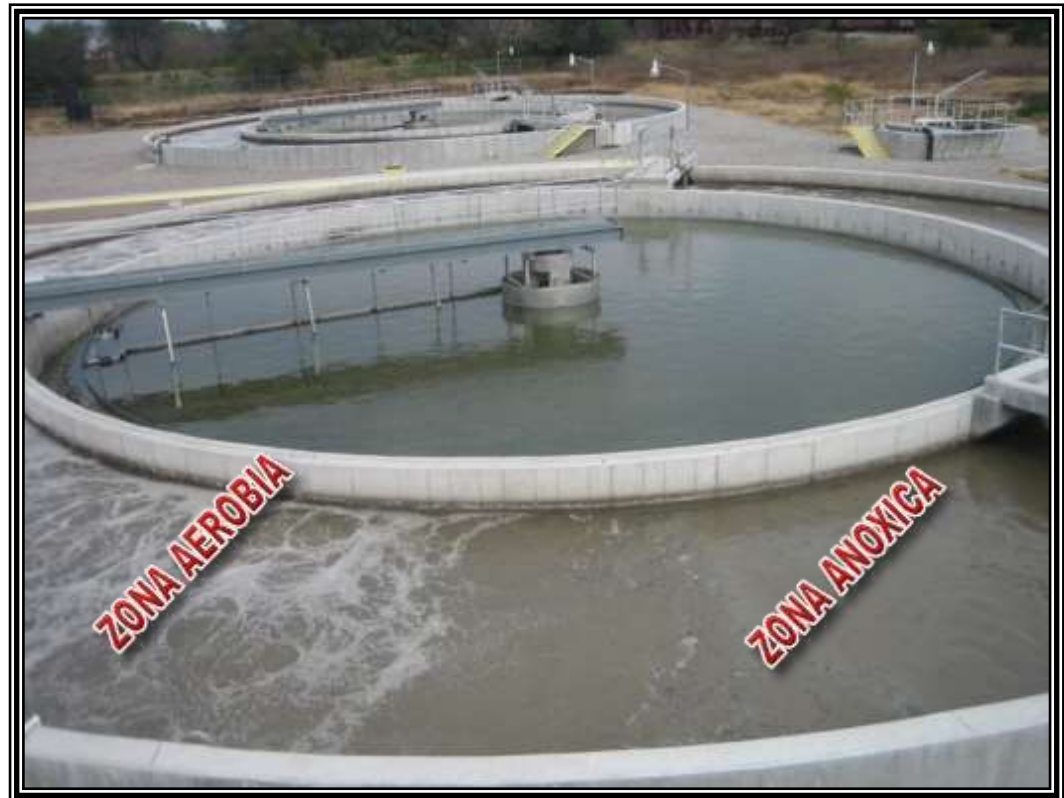
PTAR Acámbaro Gto, México 160 LPS
