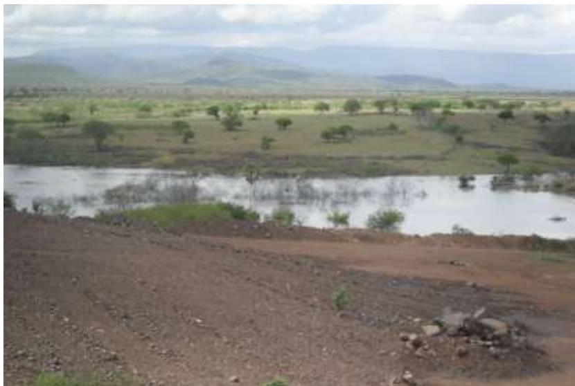
Figura 9 – Vegetação dentro do perímetro da Barragem. Fonte: Própria.
