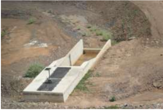
Figura 7 – Tomada d'água. Fonte: Própria.
