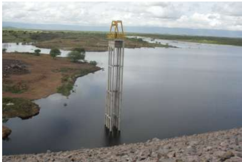
Figura 3 – Torres para regularização das águas. Fonte: Própria.
